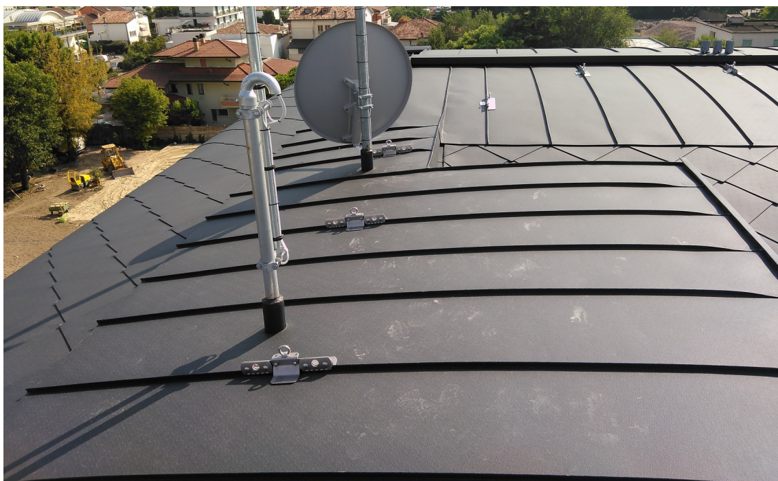
Copertura Sud-Est – Punti di ancoraggio EN 795-A
