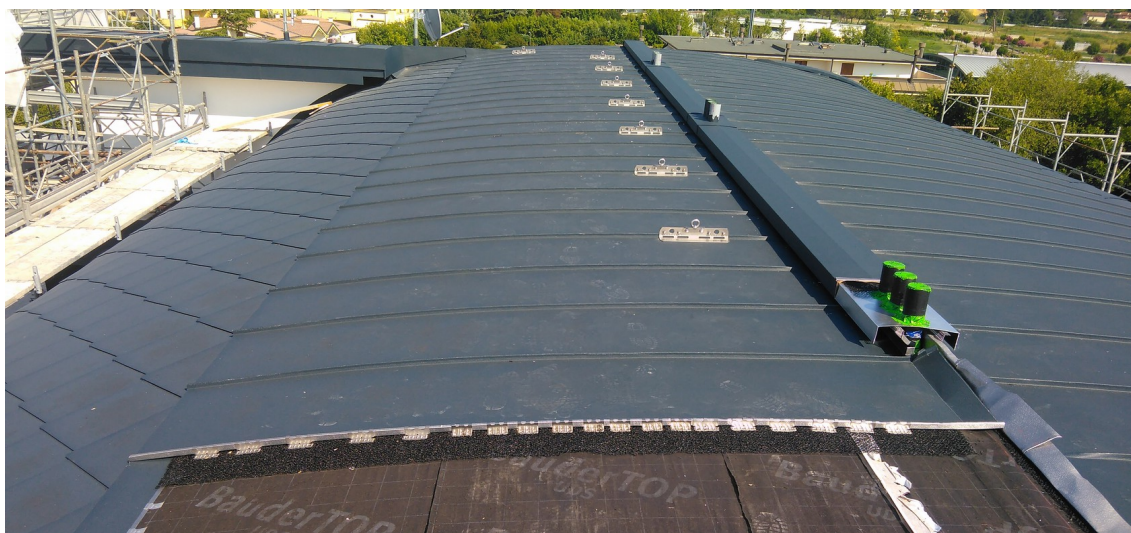
Copertura Sud – Infittimento delle graffette nella parte alta della copertura
