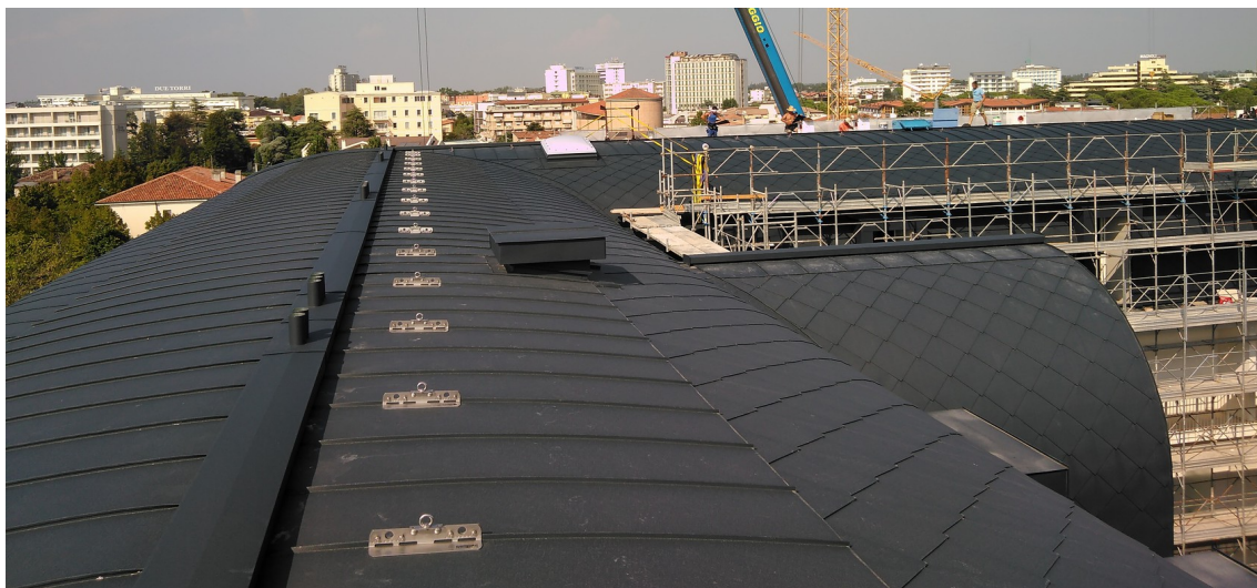
Copertura Ovest e Nord– Punti di ancoraggio EN 795-A
