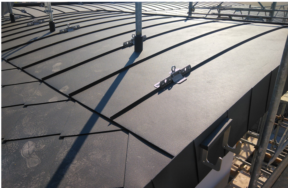
Accesso alla copertura a volta – Ganci fissi per la scala portatile e punto di ancoraggio EN 795-A di sbarco
