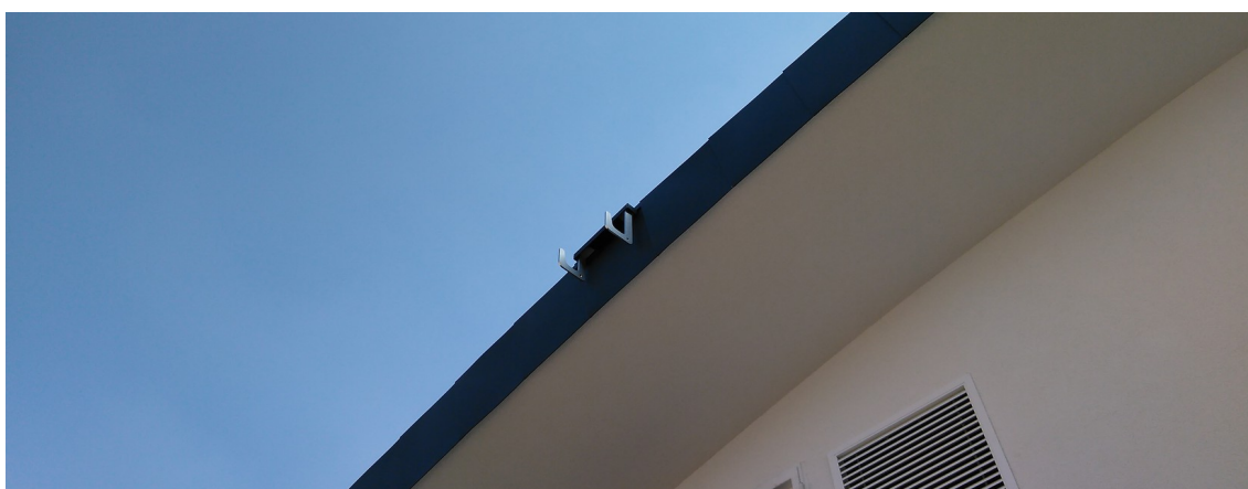
Accesso alla copertura a volta – Ganci fissi per la scala portatile
