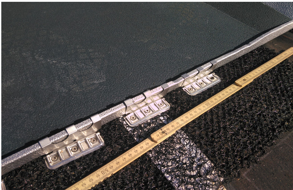
Copertura Sud – Infittimento delle graffette nella parte alta della copertura
