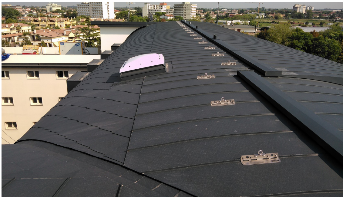
Copertura Sud – Punti di ancoraggio EN 795-A
